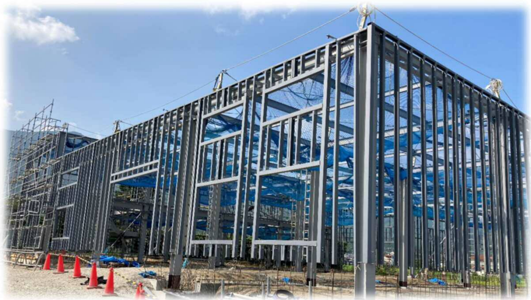
某工場鉄骨工事
