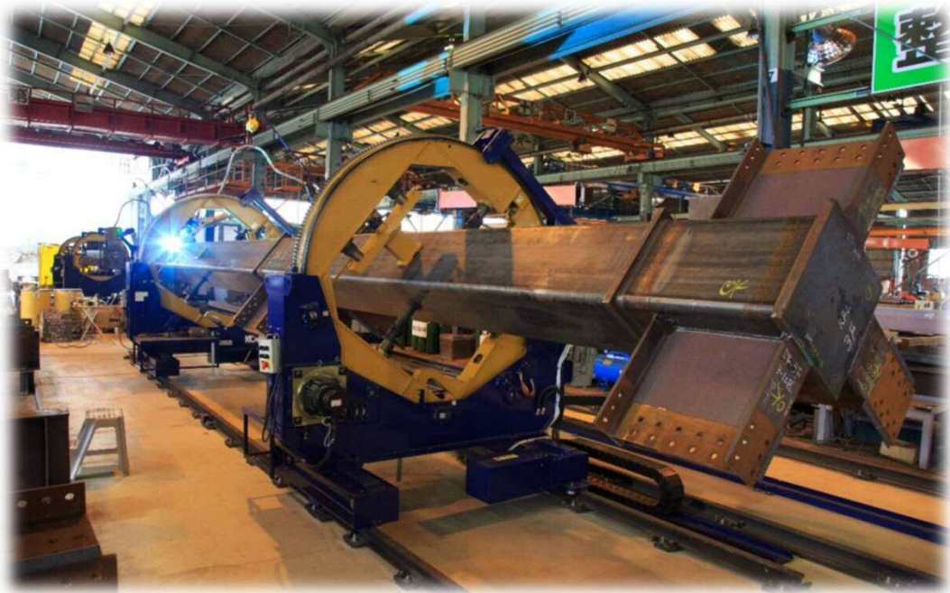
溶接 (ロボット)
