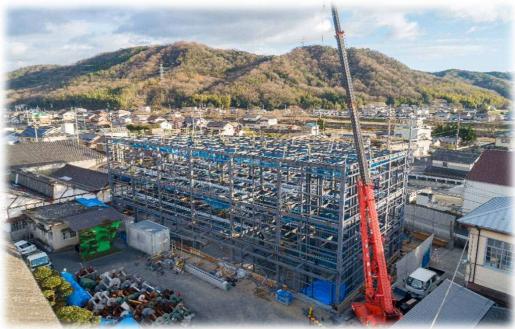
現場での建方
